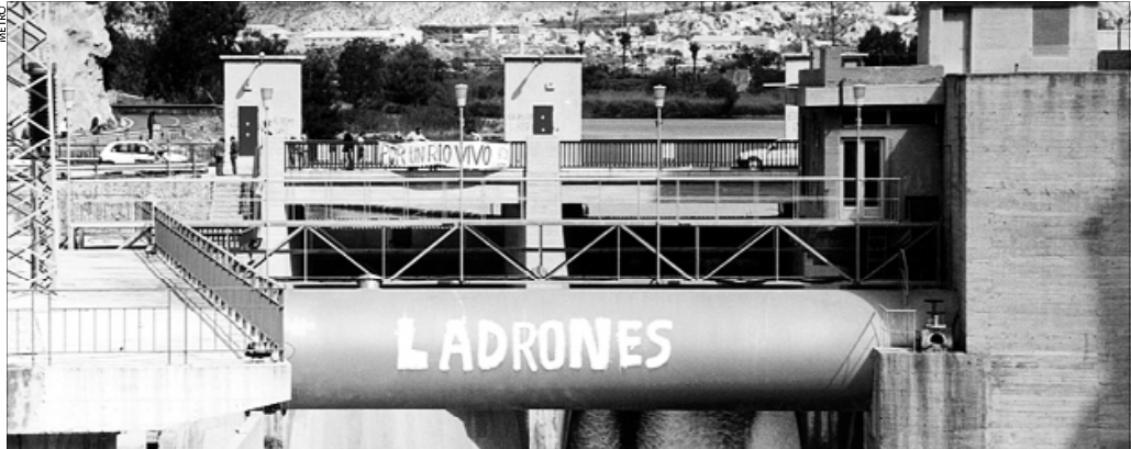
PINTADA en la Presa de Ojos (Murcia), desde donde, supuestamente, se desvía el agua del trasvase Tajo-Segura hacia fincas privadas de forma irregular.
